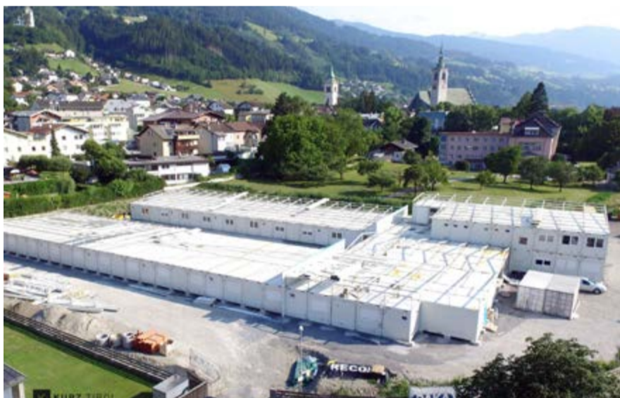
Während der Bauphase
