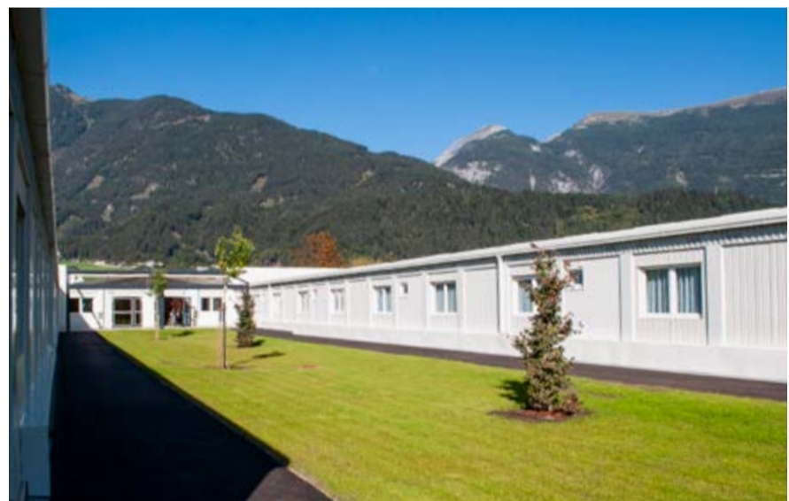
Fertigstellung 10 Monate nach dem Brand
